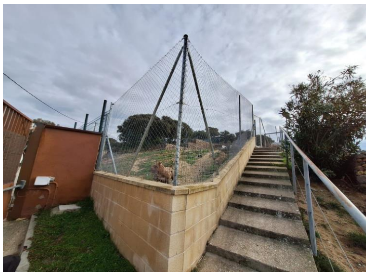
Imagen 5. Chenil exterior grande (zona escalera)
